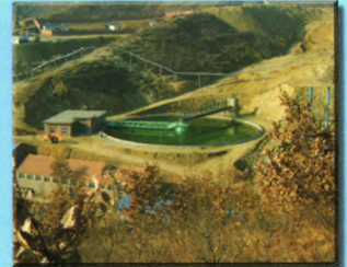
60米浓缩机及输送工程
