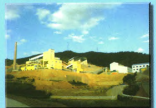
云南40万吨褐铁矿磁化焙烧工程施工现场
