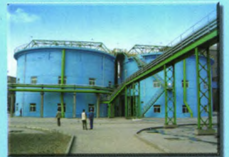
酒钢选矿厂2套 \phi 25 米高效浓缩、工程控制及输送建设承包工程
