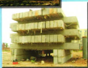
华能电厂高应变现场、静载现场
