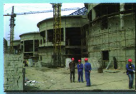
酒钢400万吨新选厂浓密机建设现场
