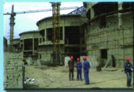
酒钢40万吨新选厂浓密机建设现场
