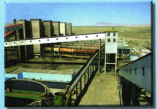
200万吨褐铁矿磁化焙烧工程施工现场
