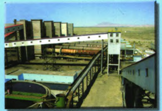
200万吨褐铁矿磁化焙烧工程施工现场
