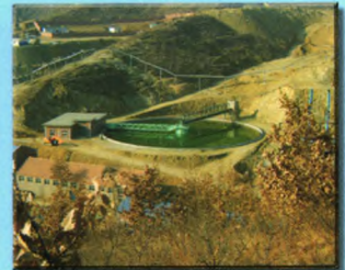
60米浓缩机及输送工程
