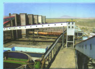
200万吨褐铁矿磁化焙烧工程施工现场
