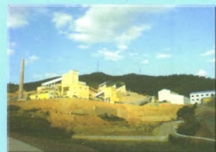
云南40万吨褐铁矿磁化焙烧工程现场
