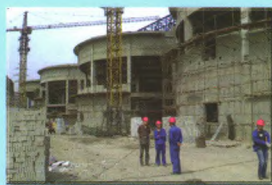
酒钢400万吨新选厂浓密机建设现场
