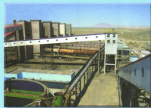
200万吨褐铁矿磁化焙烧工程施工现场
