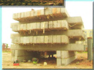
华能电厂高应变现场、静载现场
