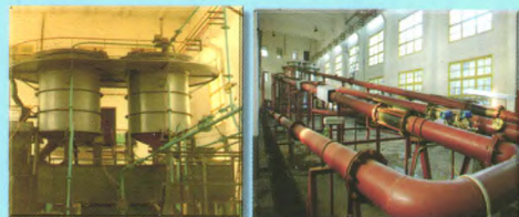
管道输送试验系统
