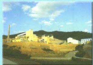
云南40万吨褐铁矿磁化焙烧工程现场
