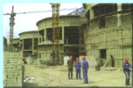
酒钢400万吨新选厂浓密机建设现场
