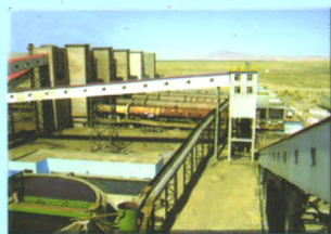
200万吨褐铁矿磁化焙烧工程施工现场
