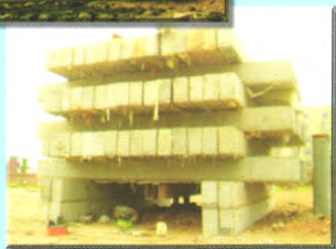
华能电厂高应变现场、静载现场
