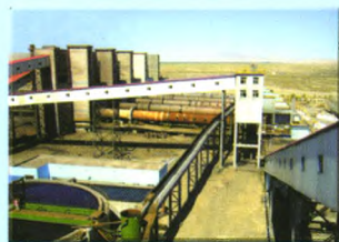
200万吨褐铁矿磁化焙烧工程施工现场
