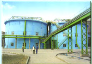
酒钢选矿厂2套Φ25米高效浓缩、工程控制及输送建设承包工程
