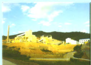
云南40万吨褐铁矿磁化焙烧工程现场
