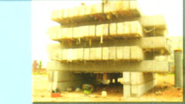
华能电厂高应变现场、静载现场
