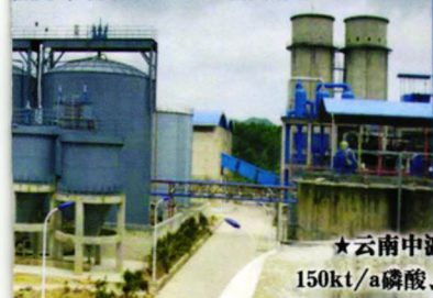
路发实业有限公司285kt/a磷酸、325kt/a粉状MAP、300kt/a DAP全套交钥匙工程
