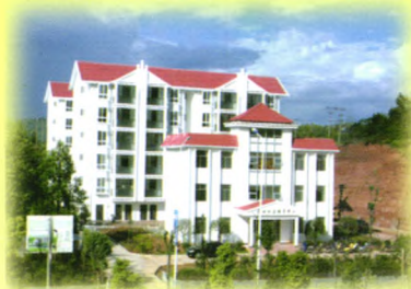
土坯房改造集中安置点
