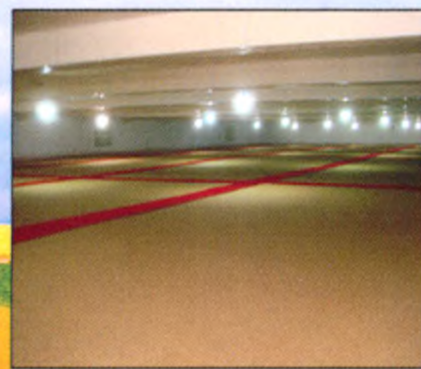
菱镁产品吊顶工程
