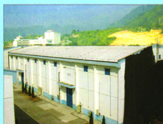
菱镁产品屋面保温隔热工程
