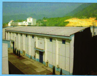
菱镁产品屋面保温隔热工程
