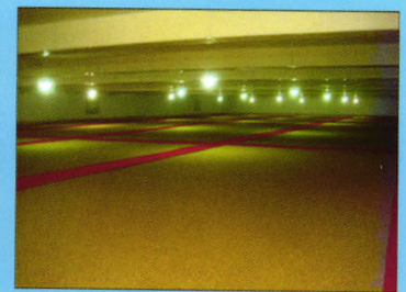
菱镁产品吊顶工程
