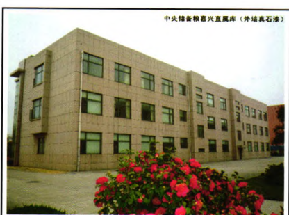
中央储备粮嘉兴直属库（外墙真石漆）
