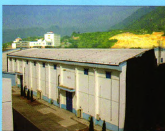
菱镁产品屋面保温隔热工程
