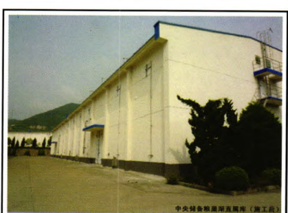
中央储备粮湖州直属库（施工后）
