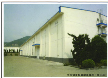
中央储备粮湖州直属库（施工后）
