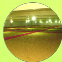
菱镁产品吊顶工程
