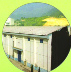
菱镁产品屋面 保温隔热工程
