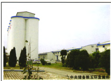
中央储备粮玉环直属库
