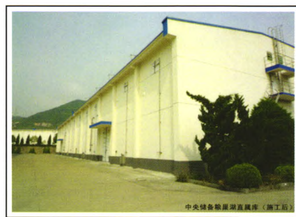
中央储备粮湖州直属库（施工后）
