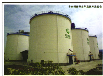
中央储备粮金华直属库浅滩分库
