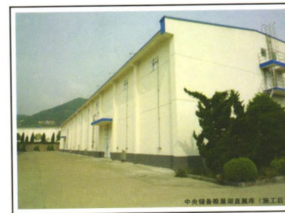
中央储备粮湖州直属库（施工后）
