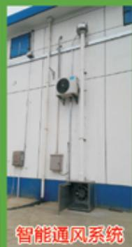
低温粮仓的综合控制系统,对仓房的外墙通风口、内环流风机和环流管道进行保温改造,减少密闭条件下仓房内部和外界环境之间的热交换。自然低温通风最大限度利用冬季的自然低温来降低粮堆的整体温度,在春夏季开启内循环,利用粮食“冷芯”的能量在不使用或少使用空调的情况下降低能耗,使整个粮堆处于低温或准低温储粮状态。
