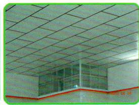
菱镁产品屋面保温隔热、吊顶工程
