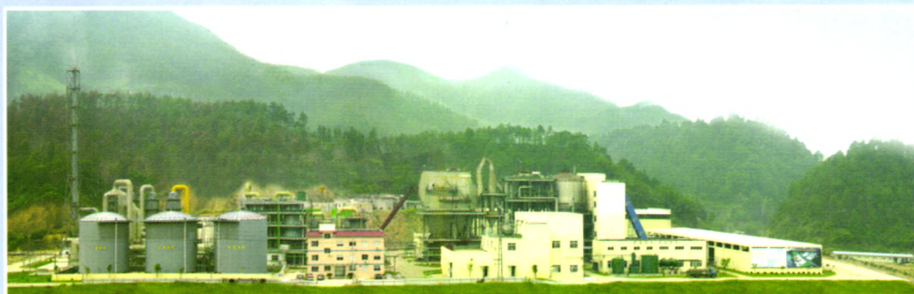
200kt/a硫精砂制酸配套6000kw余热发电装置
