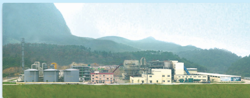
200kt/a硫精砂制硫酸配套6000kw余热发电装置
