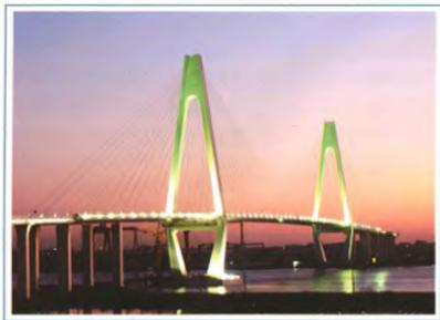
营口辽河特大桥建在辽宁省西南部大辽河入海口处,跨越大辽河,连接营口、盘锦两市,是辽宁百年建筑。大桥起点位于营口市新兴大街以北,起于滨海公路延伸线,与营口滨海公路对接;终点与营盘公路对接。辽河特大桥路线全长4.44公里,采用六车道一级公路标准,兼顾城市道路,设计时速为80公里,路基宽30.5米。主桥桥面宽32.6米,引桥桥面宽31米。这座长江以北地区跨度最大的双塔双索面斜拉桥为滨海公路上最后一个通车的节点,使滨海公路全线贯通。2008年8月11日,营口辽河特大桥正式开工,2010年7月22号合龙,2010年9月28日正式通车。该桥创造了全国、东北地区多个第一,为辽宁省标志性建筑之一。
