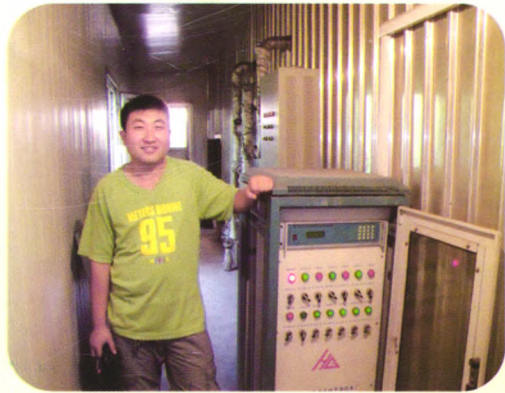
节能系统安装调试
