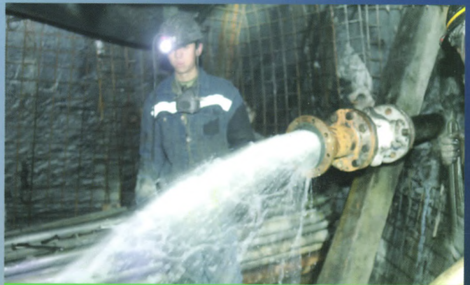
唐家会煤矿首采区61101工作面定向钻孔放水现场
