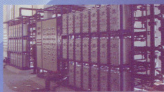
4 × 300MW 亚临界机组 投运时间: 2006年 EDI产水量: 7680m 3 /d 产水水质: 17兆欧
