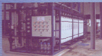
江苏某“零排放”项目 投运时间: 2009年 超滤产水量: 22000m 3 /d 膜组件数量: 250支 水源: 园区废水
