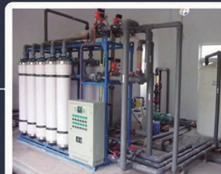
垃圾焚烧厂渗透液
