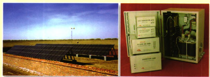
风光互补村落供电系统
