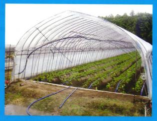
无论是连栋温室、日光温室或是塑料大棚, 其承力结构基本都是一种典型的排架结构。在受 到垂直于山墙分向力(主要来自风力)的作用下, 独立的排架结构本身没有能力传递从纵向传来 的力,而要依靠纵向系杆和斜撑来将其传递到排 架,再通过排架传递到基础。纵向系杆是垂直于 排架的传力构件,一般通长布置,将所有的排架 连为一体,但纵向系杆和排架骨架(拱杆)形成的 四边形结构,在纵向风力的作用下如果连接节点 发生松动容易发生平行四边形变形……
