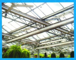
温室的室内遮阳保温幕既具有白天降低室内光照强度、降低空气温度的作用,还具有夜间降低室内加温空间、增强温室保温能力的功能,因此,不论是南方地区还是北方地区建造温室,室内遮阳保温幕几乎成为了温室设备的基本配置……
