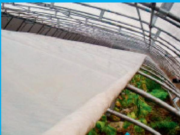
日光温室保温被一般采用外覆盖的形式,即保温被覆盖在温室塑料薄膜的外表面。这种覆盖方式安装简单,操作方便,因此被温室生产者广泛采用。但这种覆盖方式也存在一些难以克服的固有缺陷:首先,这种覆盖方式由于受到室外天气条件的影响,在不同程度上会影响保温被的保温性能和使用寿命,如刮风天气,保温被表面风速加大,有时甚至会有冷风直接侵入保温被下雨雪天,保温被表面会被淋湿,甚至整个保温被被雨水浸透,上述天气条件均会增大保温被的导热能力,降低保温性能……
