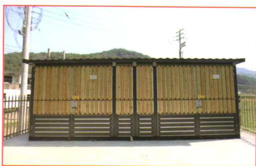
已投运工程实景图
