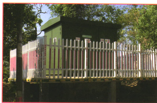
已投运工程实景图
