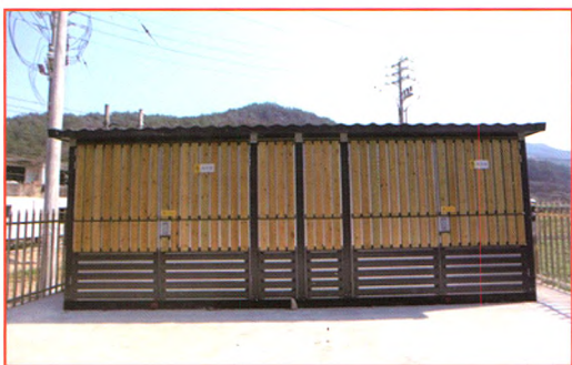
已投运工程实景图
