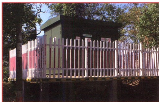
已投运工程实景图
