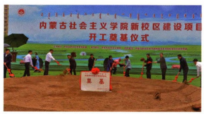
开工奠基现场
