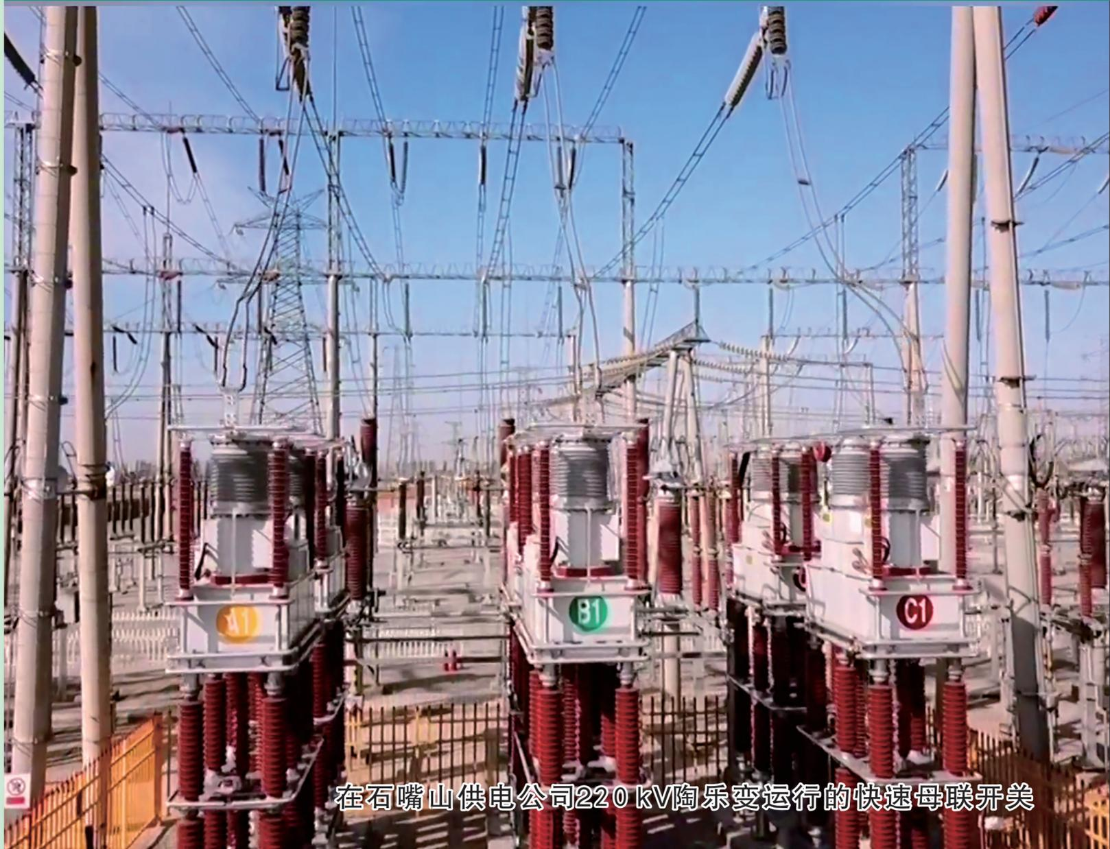
在石嘴山供电公司220 kV陶乐变运行的快速母联开关
