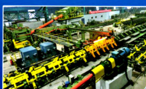
中厚壁无缝钢管生产线
