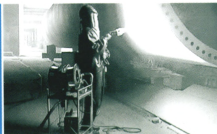
电弧喷涂机在喷涂西门子风电塔筒
