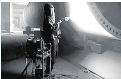
电弧喷涂机在喷涂西门子风电塔筒
