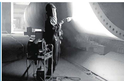
电弧喷涂机在喷涂西门子风电塔筒
