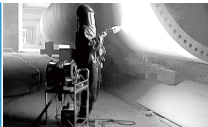
电弧喷涂机在喷涂西门子风电塔筒
