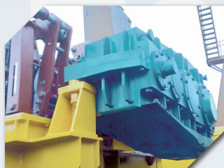
FC减速器安装现场
