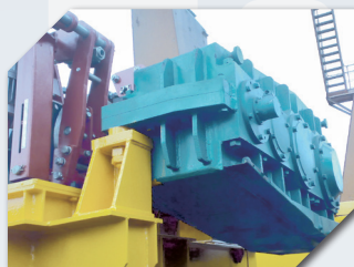
FC减速器安装现场
