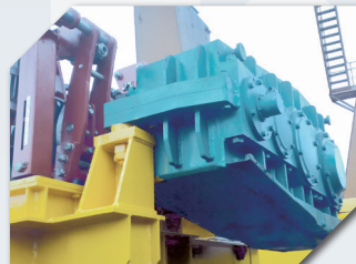
FC减速器安装现场
