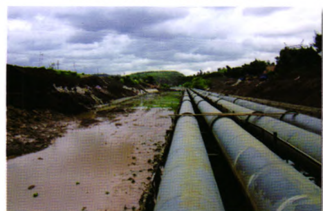
安宁市鸣矣河治理工程
