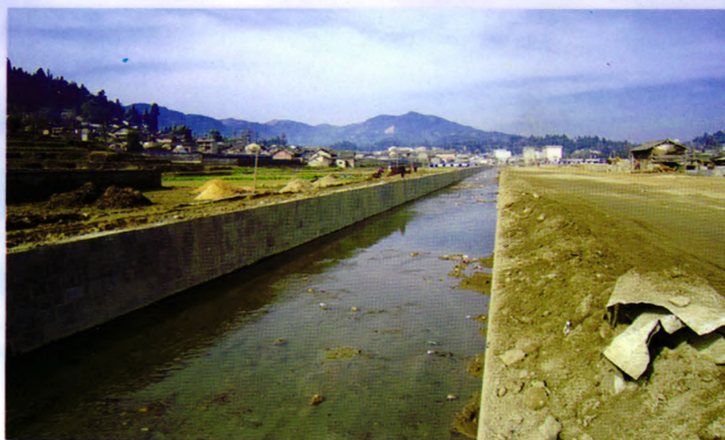
龙陵县苏帕河象达段治理工程
