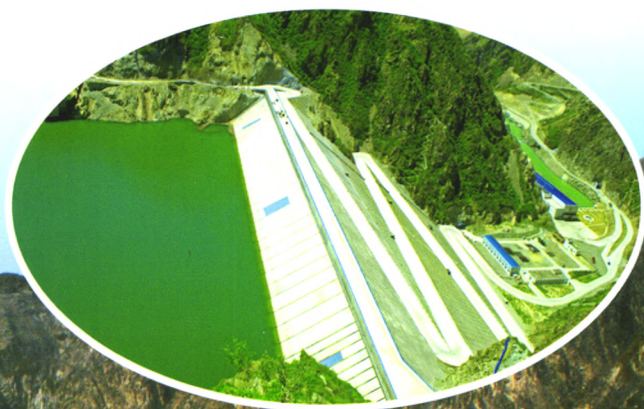
竣工后的吉林台一级水电站
