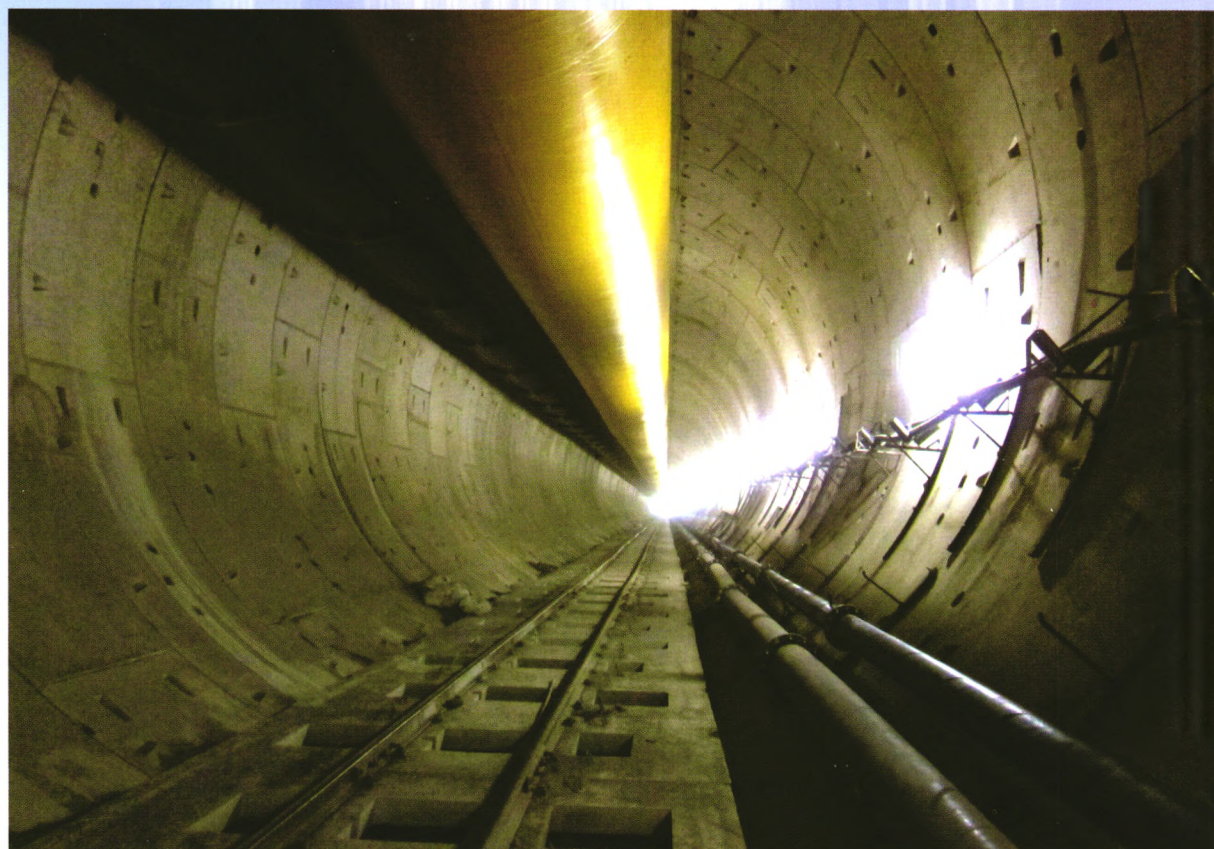
厄瓜多尔CCS项目管片安装后的隧洞
