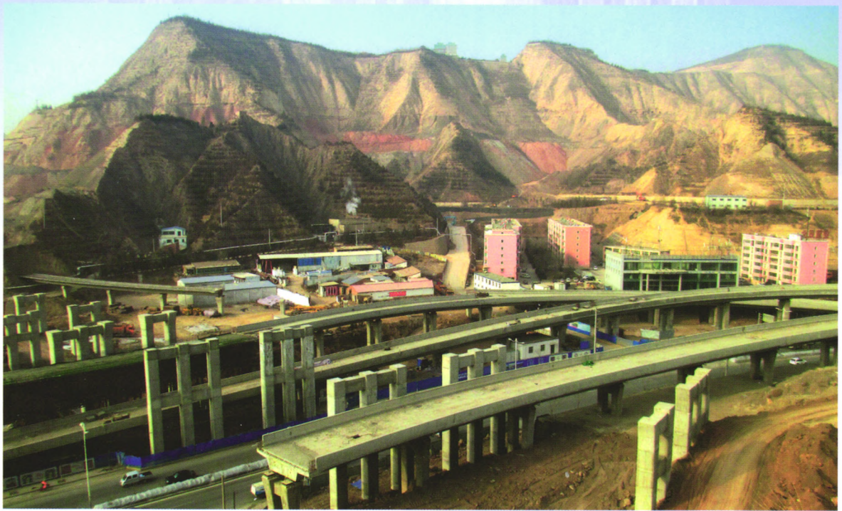
兰州市北环路东线一标大砂沟互通立交全貌图
