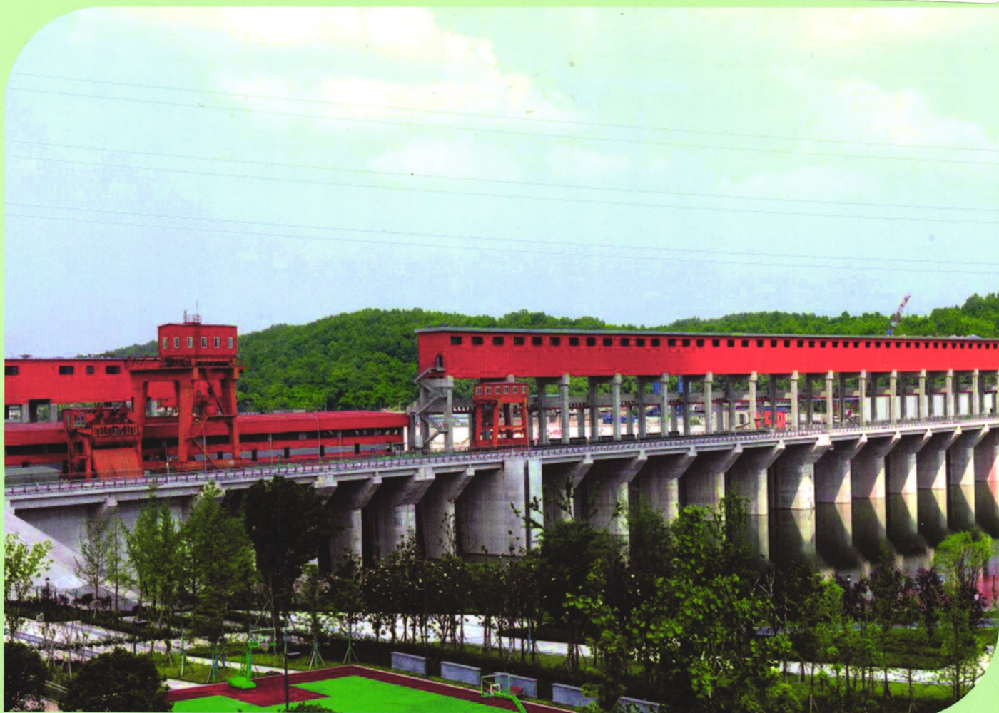
重庆航发潼南航电枢纽工程
