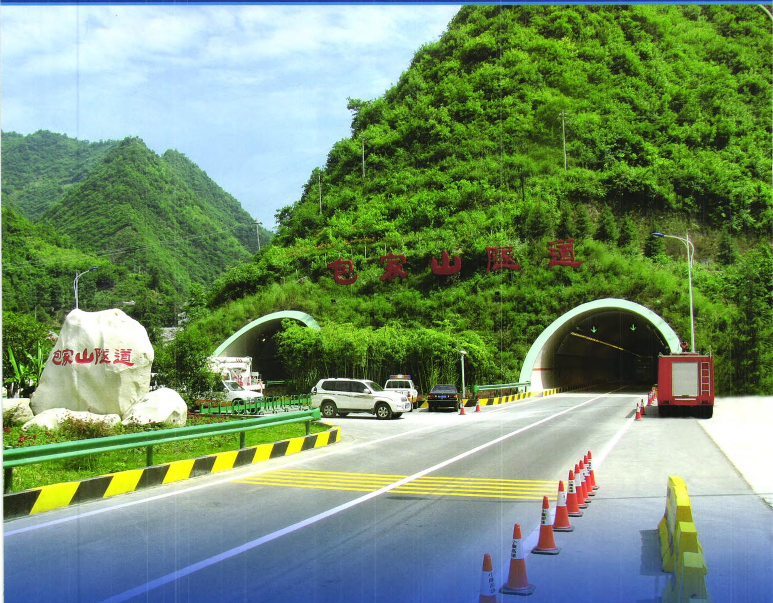
包家山隧道地处小康新高速的咽喉部位，全长11.2 km，是包茂高速公路小河至安康段的关键控制性工程。该隧道地质结构极其复杂，通过地段以千枚岩、片岩为主，穿越37条断层和多处破碎带，经历了7次大的涌水，146次涌水涌沙、突泥，168次大小塌方及雪灾、地震等地质和自然灾害。2013年，包家山隧道工程荣获第十一届中国土木工程詹天佑奖。
