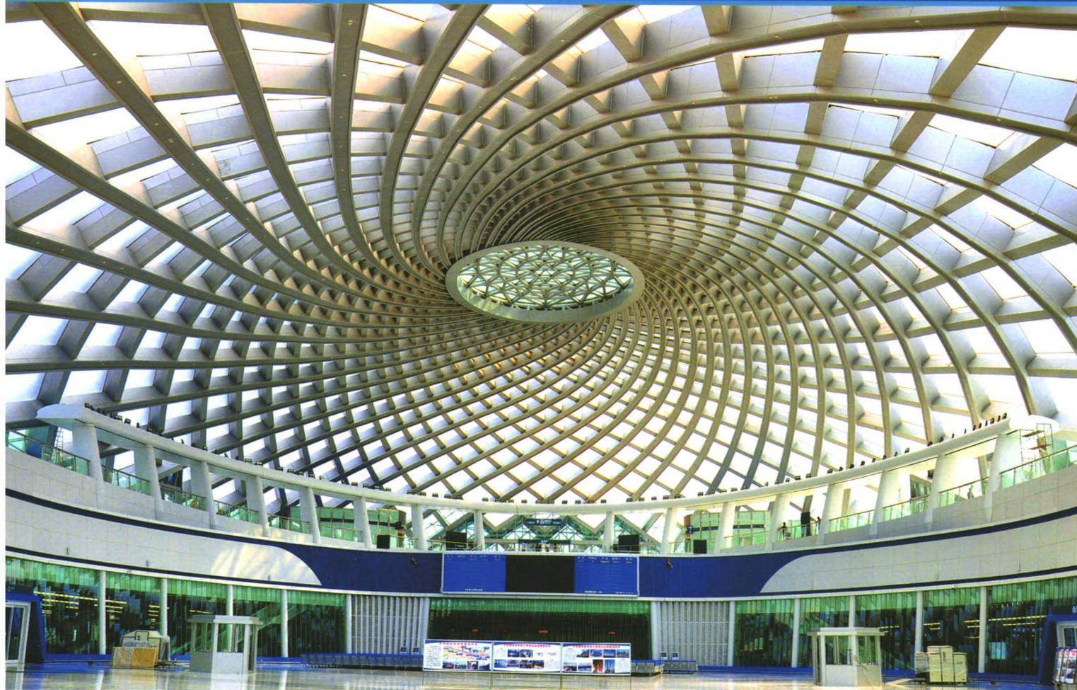
于家堡站综合交通枢纽以京津城际铁路延伸线终点站——于家堡站为核心，配套轨道交通Z4、B2、Z1三线的预留车站工程及公交车辆停车场、社会车辆停车场、公交中心、控制中心等市政工程。除地面采光穹顶外，全部结构位于地下，是国内首个建成通车的地下火车站。枢纽地下结构建筑面积约27万m<sup>2</sup>，占地超过13万m<sup>2</sup>，为超大、超深规模地下结构。枢纽地面采光穹顶的网壳设计灵感来源于鹦鹉螺和向日葵的螺旋线，由72根正反螺旋型的网格交叉编制而成，其独特的造型成为天津滨海新区的地标建筑。
