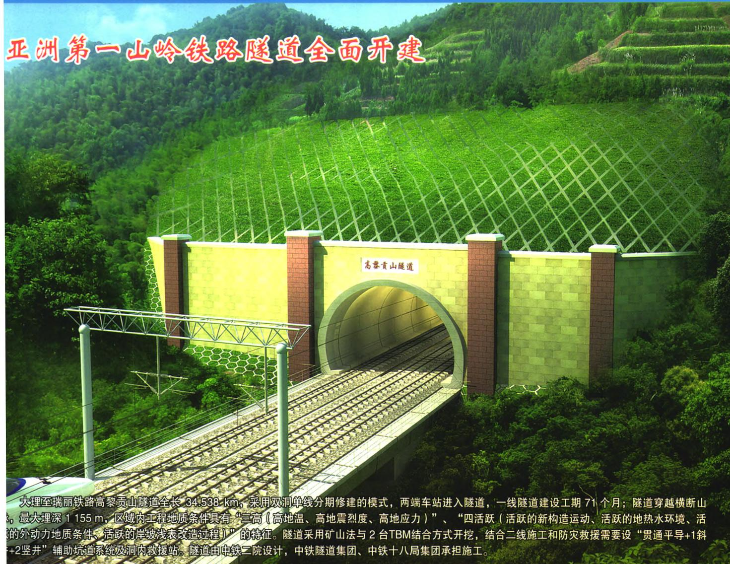
大理至瑞丽铁路高黎贡山隧道全长 34.538 km，采用双洞单线分期修建的模式，两端车站进入隧道，一线隧道建设工期 71 个月；隧道穿越横断山脉，最大埋深 1 155 m，区域内工程地质条件具有“三高（高地温、高地震烈度、高地应力）”、“四活跃（活跃的新构造运动、活跃的地热水环境、活跃的外动力地质条件、活跃的岸坡浅表改造过程）”的特征。隧道采用矿山法与 2 台 TBM 结合方式开挖，结合二线施工和防灾救援需要设“贯通平导+1 斜井+2 竖井”辅助坑道系统及洞内救援站。隧道由中铁二院设计，中铁隧道集团、中铁十八局集团承担施工。
