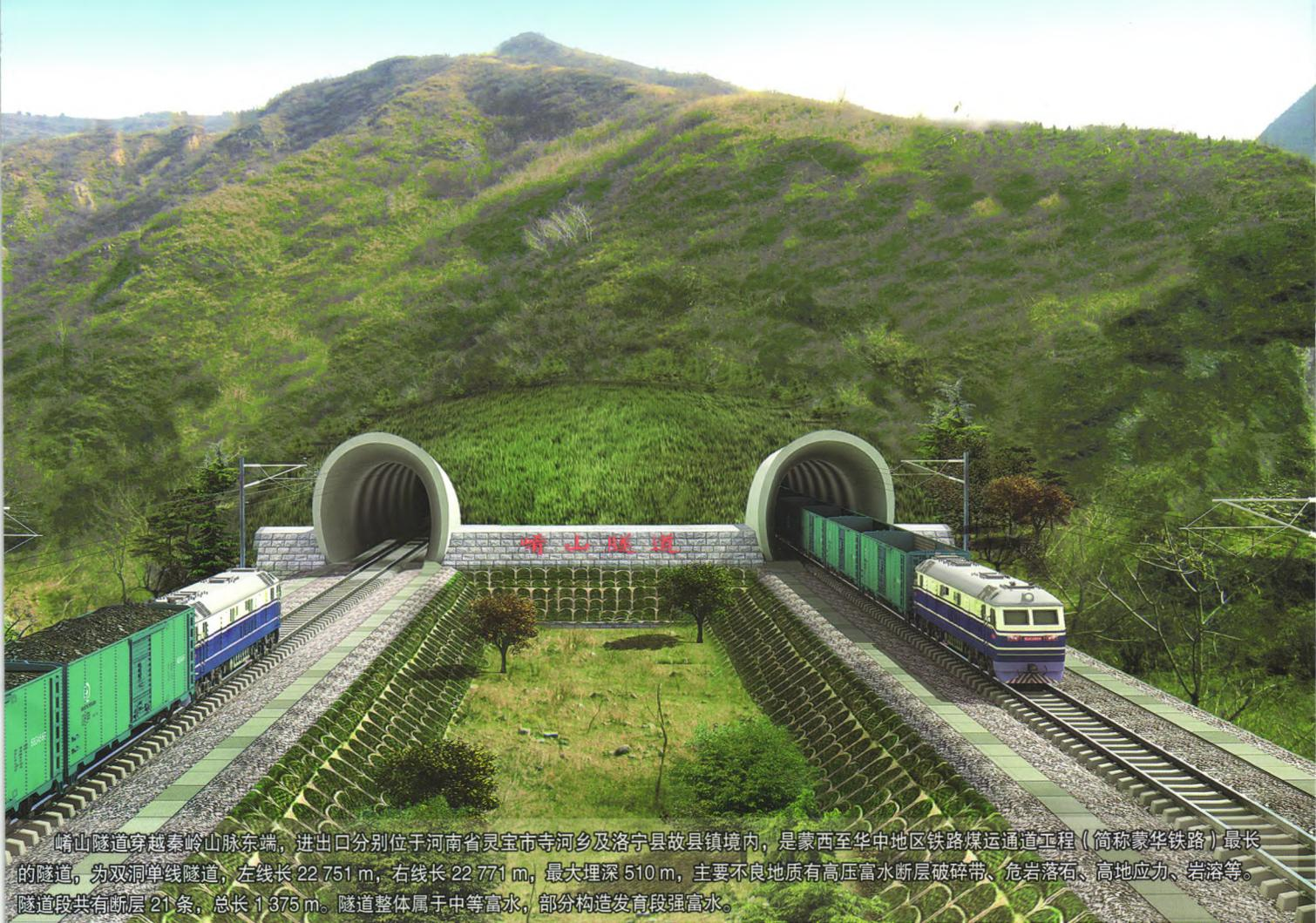
崤山隧道穿越秦岭山脉东端，进出口分别位于河南省灵宝市寺河乡及洛宁县故县镇境内，是蒙西至华中地区铁路煤运通道工程（简称蒙华铁路）最长的隧道，为双洞单线隧道，左线长 22 751 m，右线长 22 771 m，最大埋深 510 m，主要不良地质有高压富水断层破碎带、危岩落石、高地应力、岩溶等。隧道段共有断层 21 条，总长 1 375 m。隧道整体属于中等富水，部分构造发育段强富水。
