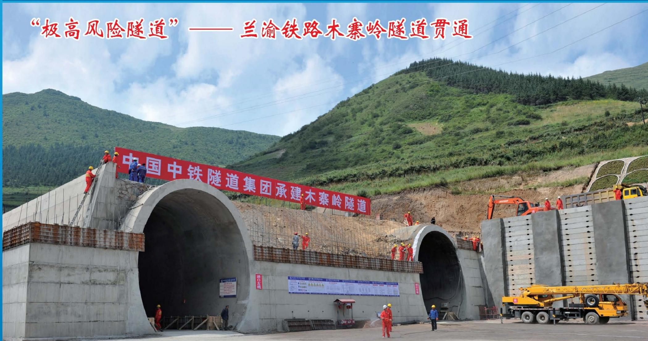
2016年7月18日，经过80个月的鏖战，被国内外专家称为“国内之最，世界罕见”的“极高风险隧道”——兰渝铁路木寨岭隧道成功贯通，标志着我国在攻克世界级隧道施工难题——极高地应力软岩大变形隧道施工方面取得了重大突破。木寨岭隧道全长19.1 km，为双洞单线分离式特长隧道。隧道地质条件极其复杂，共经过包括区域性大断层在内的11条断裂带，高地应力软岩地段占全隧长度的84.5%，最大地应力27.16 MPa，处于极高地应力区域。变形大而且快，地质流变性极强，极易坍塌，为全线唯一动态设计、动态施工的隧道项目。最终采用全国独有的“小导洞应力释放+三层初期支护+长锚索+单层二次衬砌、圆形断面结构”的兰渝铁路“木寨岭模式”推进隧道建设，有效控制了极高地应力软弱围岩条件下的隧道大变形问题。
