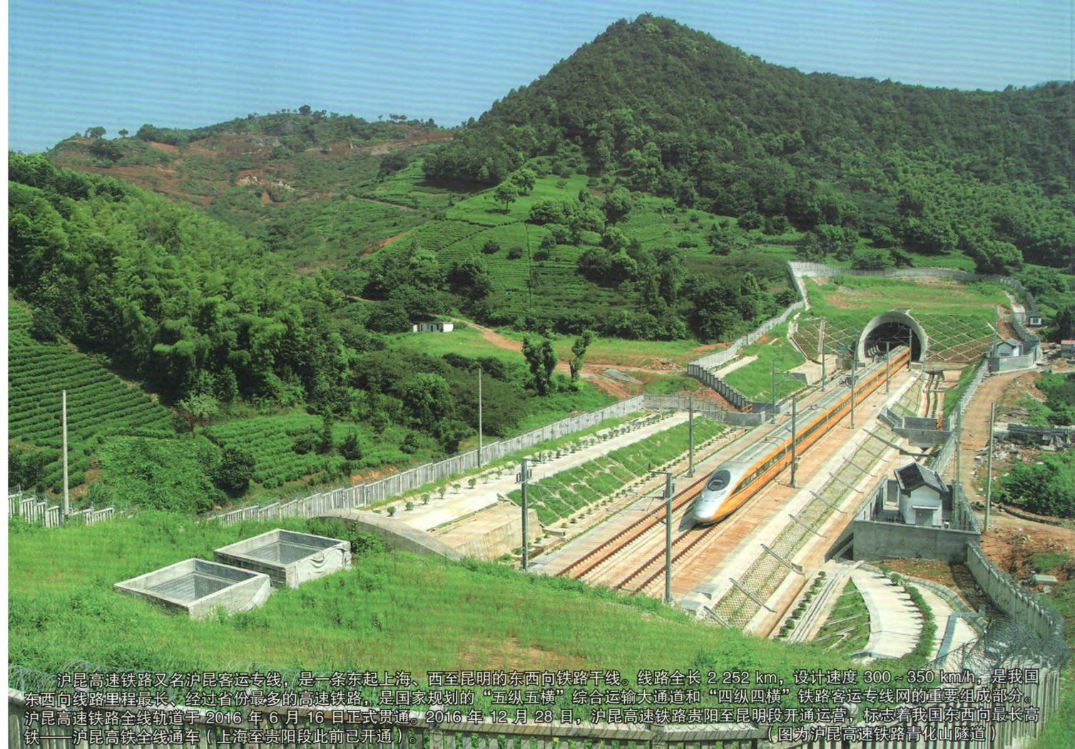
沪昆高速铁路又名沪昆客运专线，是一条东起上海、西至昆明的东西向铁路干线。线路全长 2 252 km，设计速度 300~350 km/h，是我国东西向线路里程最长、经过省份最多的高速铁路，是国家规划的“五纵五横”综合运输大通道和“四纵四横”铁路客运专线网的重要组成部分。沪昆高速铁路全线轨道于 2016 年 6 月 16 日正式贯通。2016 年 12 月 28 日，沪昆高速铁路贵阳至昆明段开通运营，标志着我国东西向最长高铁——沪昆高铁全线通车（上海至贵阳段此前已开通）。
