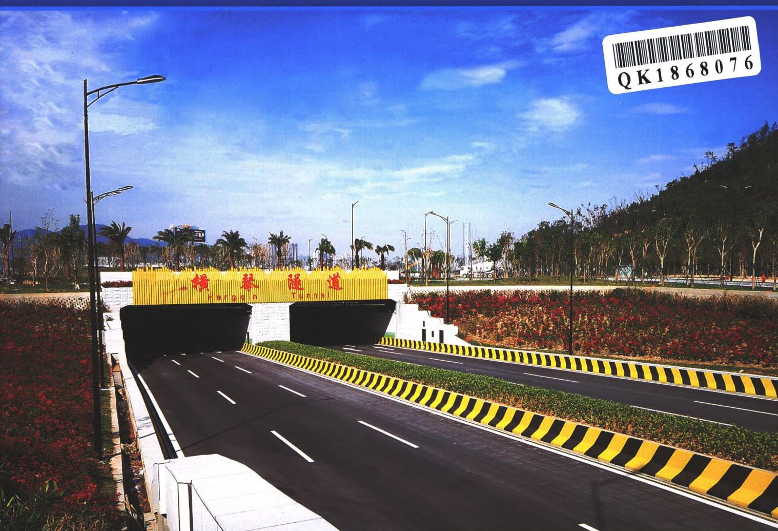
2018年11月1日，由隧道股份上海隧道工程有限公司承建的珠海横琴隧道（原马骝洲交通隧道）通车试运行。工程总投资为25.44亿元，隧道全长2 836.84 m，为主线双向6车道，采用1台直径14.93 m的泥水气平衡盾构施工，是华南地区首条超大直径盾构隧道，也是我国首条海域超大直径复合地层盾构隧道。施工方通过采用先进高效的探障手段和清障工艺对隧道全线障碍物进行超前预处理，同时对盾构进行针对性改造以提高盾构的地质适应性，解决了“抛石多、覆土浅、岩面高”等技术难题，盾构在复合地层最高月进尺达250 m。项目成果可为该地区同类地下工程的建设提供借鉴，拓宽了盾构法隧道的地层适应范围。
