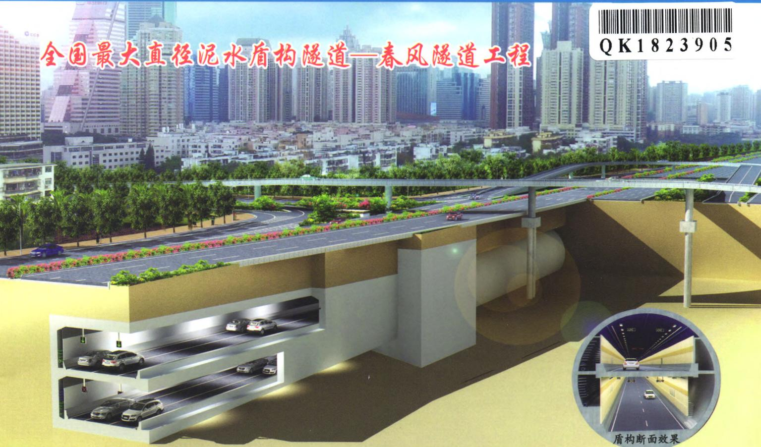
春风隧道工程位于深圳市老城区，是国内最大直径泥水盾构隧道（刀盘直径 15.80 m），也是深圳市首条采用盾构技术施工的机动车隧道及首条单洞双层构造的机动车隧道。工程路线全长约 5 178 m，隧道长 4 799 m，盾构段长 3 603 m，地处滨海区域，地质环境、水文环境复杂，且隧道穿越长距离的软硬不均、硬岩地层及多条破碎带，施工场地狭窄，周边环境复杂，建筑物、管线众多，交通流量大，工程综合难度和风险在目前世界同类型工程中最高。该工程采用EPC模式建设，由中铁隧道局集团有限公司负责工程总承包。
