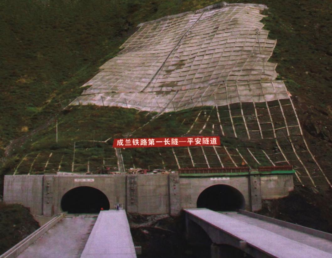
成兰铁路是四川西部第一条铁路，鉴于项目复杂的地质条件和敏感的区域环境，确定将成都至川主寺（黄胜关）段作为工程试验段建设。试验段全长275.8 km，隧道17座，总延长175.5 km，隧线比为63.6%。其中平安隧道长28.4 km，是我国目前西南山区最长铁路隧道；云中堡隧道长22.923 km，是我国目前最长的双线铁路隧道。受“5·12”汶川地震和余震影响，地质风险和环境风险进一步叠加，隧道内外不良地质问题进一步恶化，给工程修建和建设管理增大了难度。针对工程推进异常艰难的实际情况，结合本线“穿越地震区、环保区+长大深埋隧道群”的特点，建设单位组织相关单位以国内已有的、成熟的技术成果为依托，尊重科学，集成创新，探索出一套复杂艰险山区隧道工程的修建技术，为我国西南山区铁路建设积累了经验。
